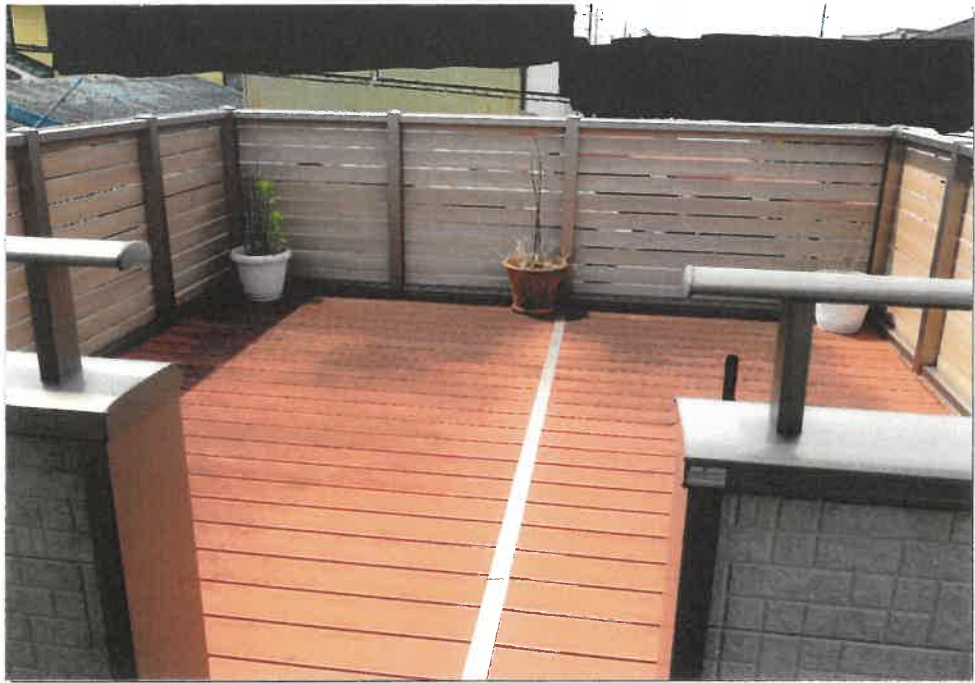
⑦ カーポートの屋根上に設置されたデッキ
