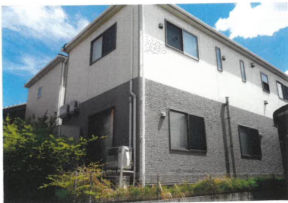
② 物件2建物の外観
