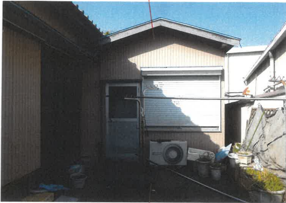
⑪屋外の状況
