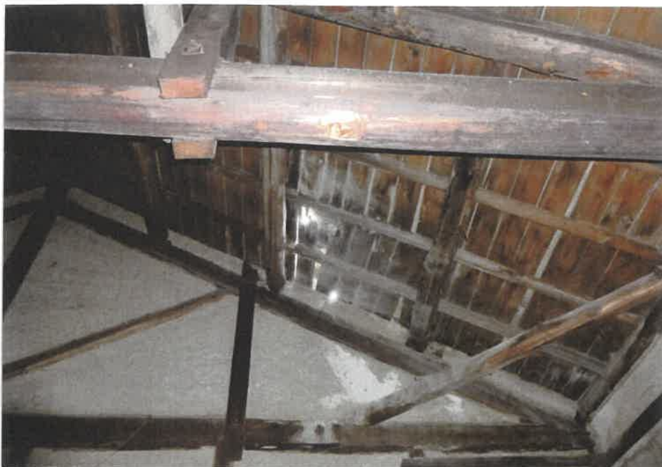
③屋内の状況 天井の状況 (物件3)
