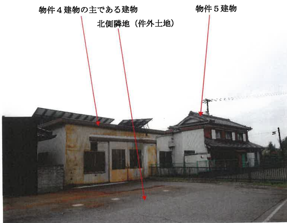
② 物件4建物及び物件5建物の外観
