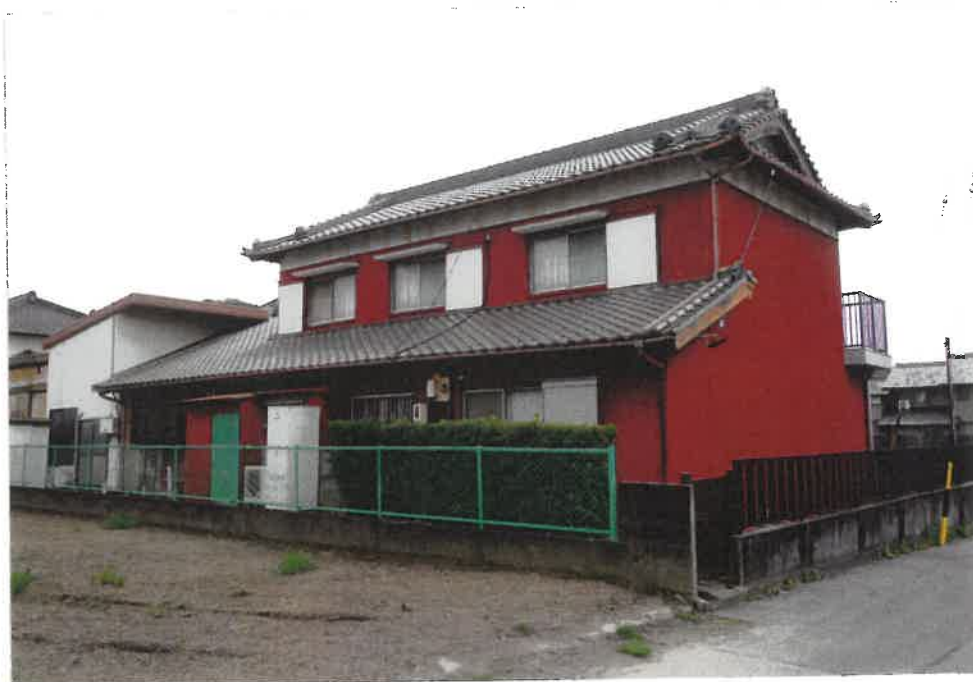
④ 物件5建物の外観
