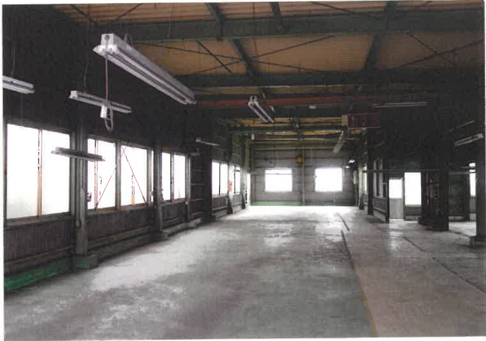
⑤ 屋内の状況（物件4建物・工場部分）
