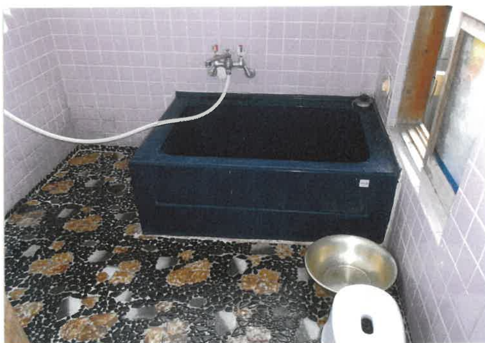
④屋内の状況 浴室
