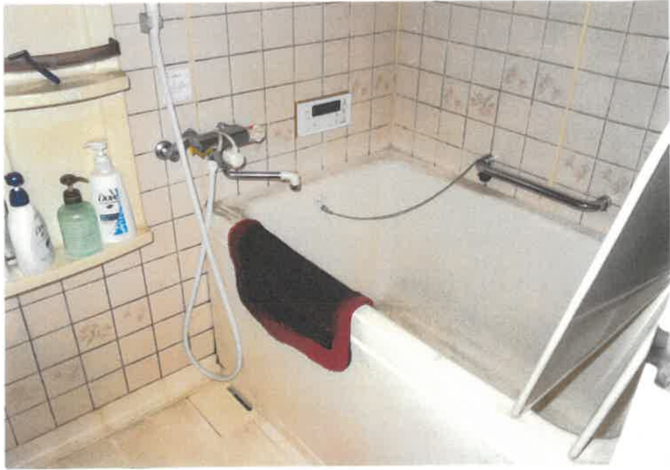
⑤ 屋内の状況（浴室）
