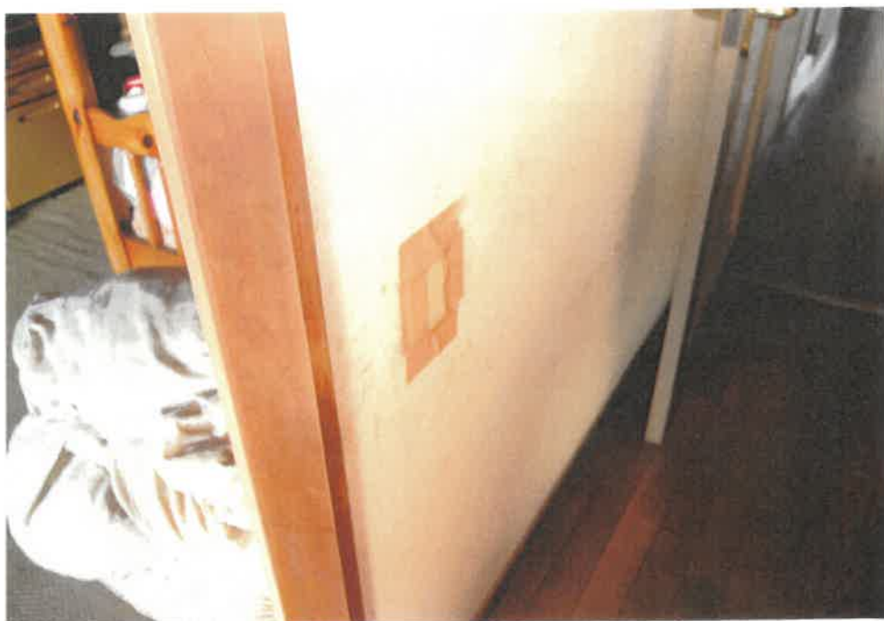
⑧ 穴開きの損傷の補修箇所
