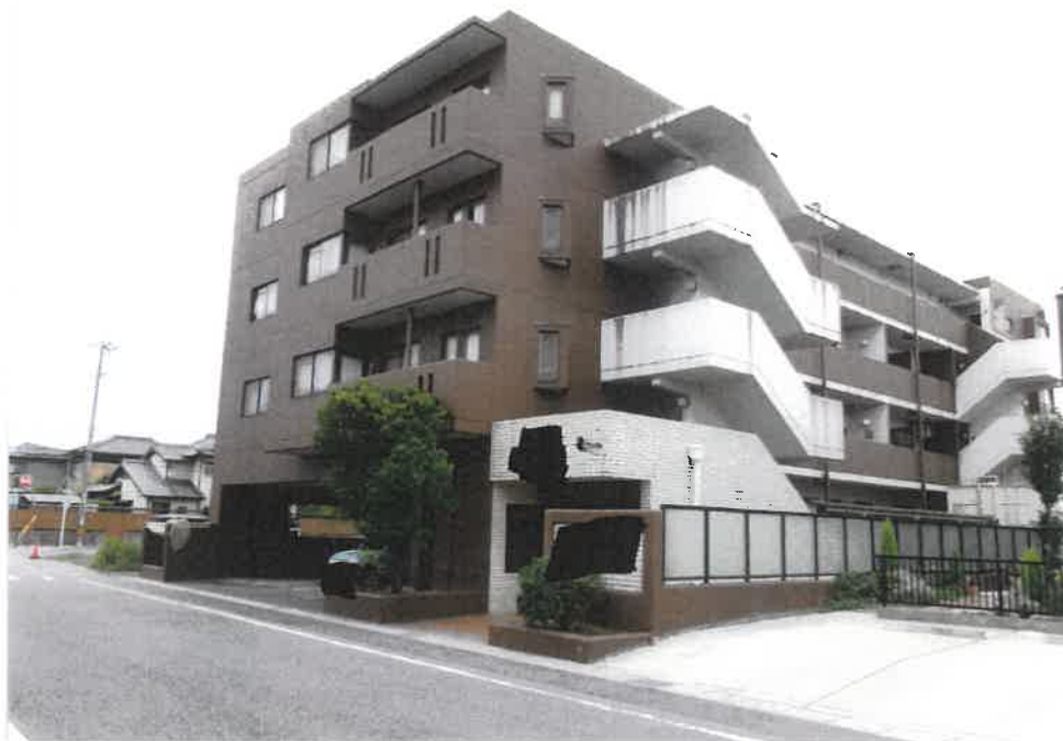
①本件建物を含む一棟の建物
