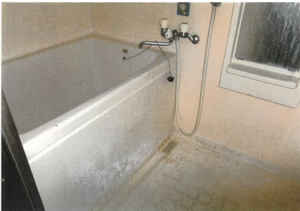
④屋内の状況 浴室
