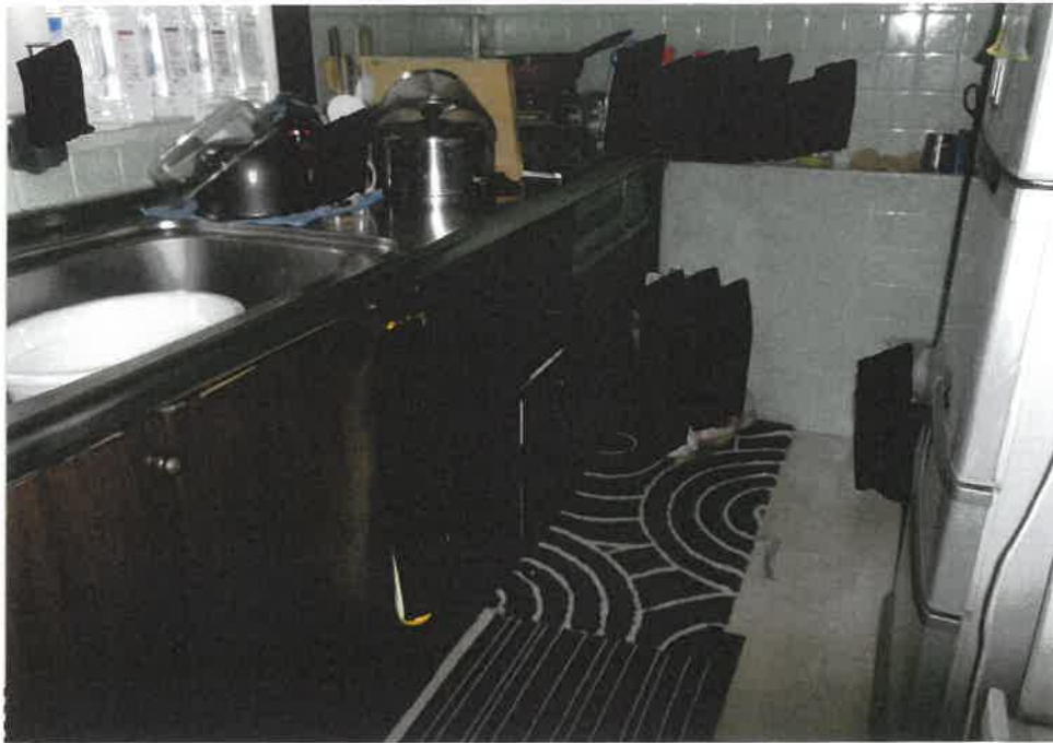
③屋内の状況 キッチン
