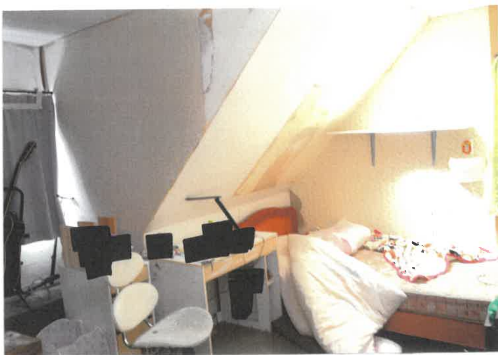
⑪ 壁紙クロスの剥離
