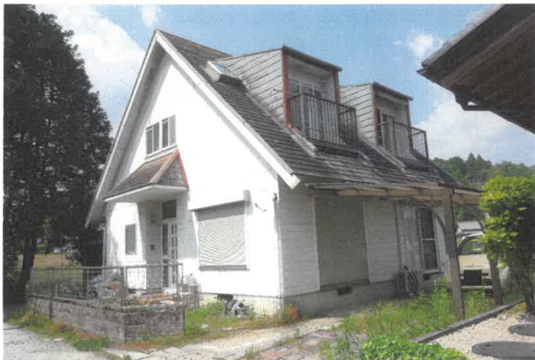
① 物件4建物の主である建物の外観
