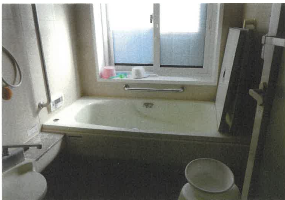
④屋内の状況 浴室
