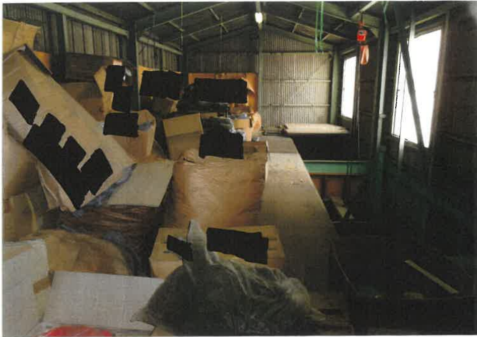
③屋内の状況 倉庫
