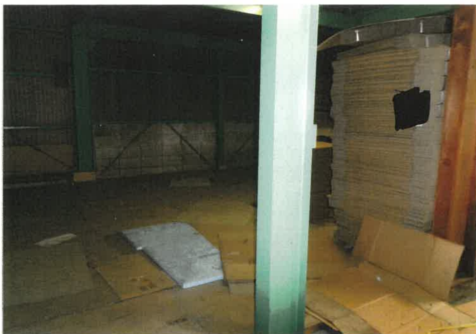
②屋内の状況 倉庫・作業場
