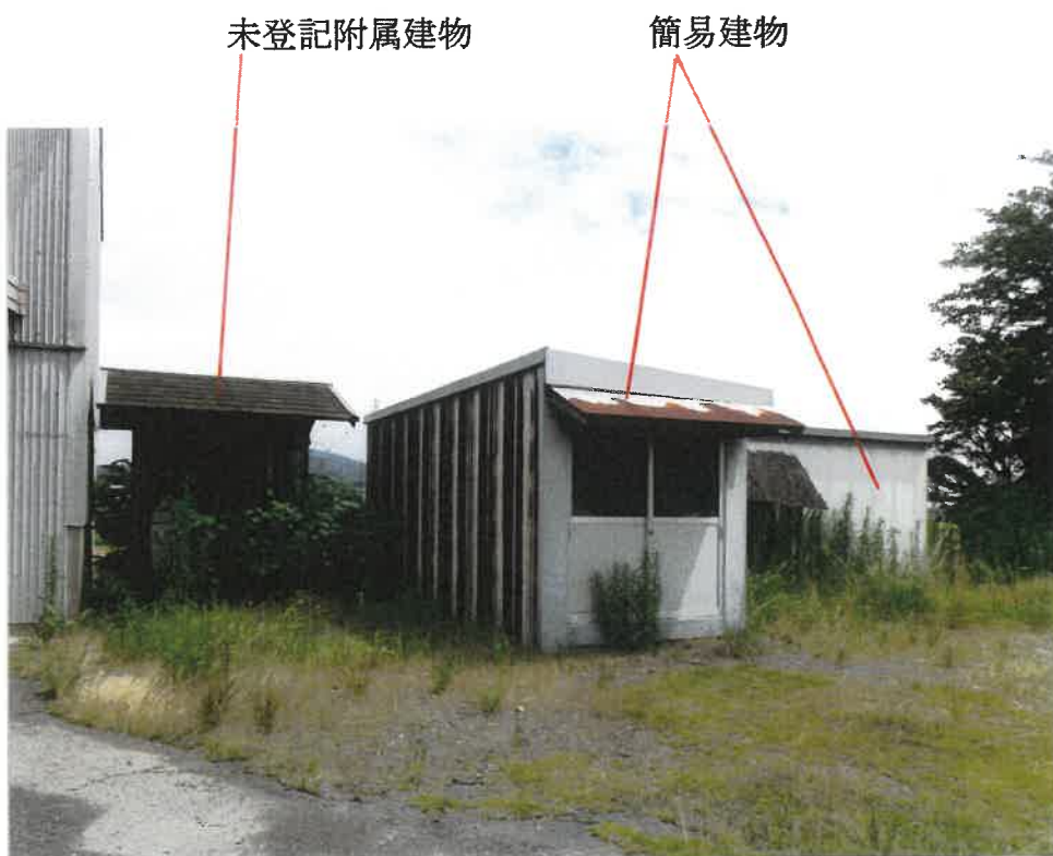
④屋外の状況
