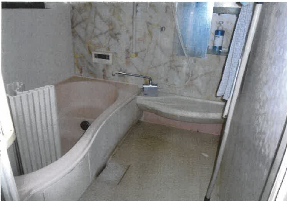
④屋内の状況 浴室
