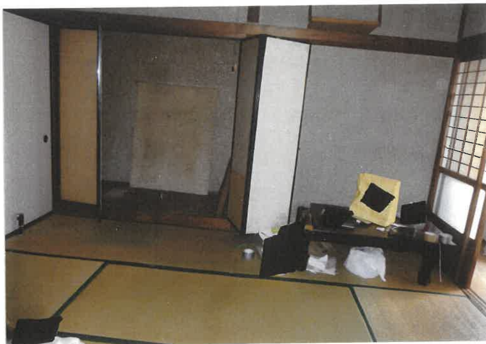
⑥屋内の状況 和室3 (物件4) (主である 建物)
