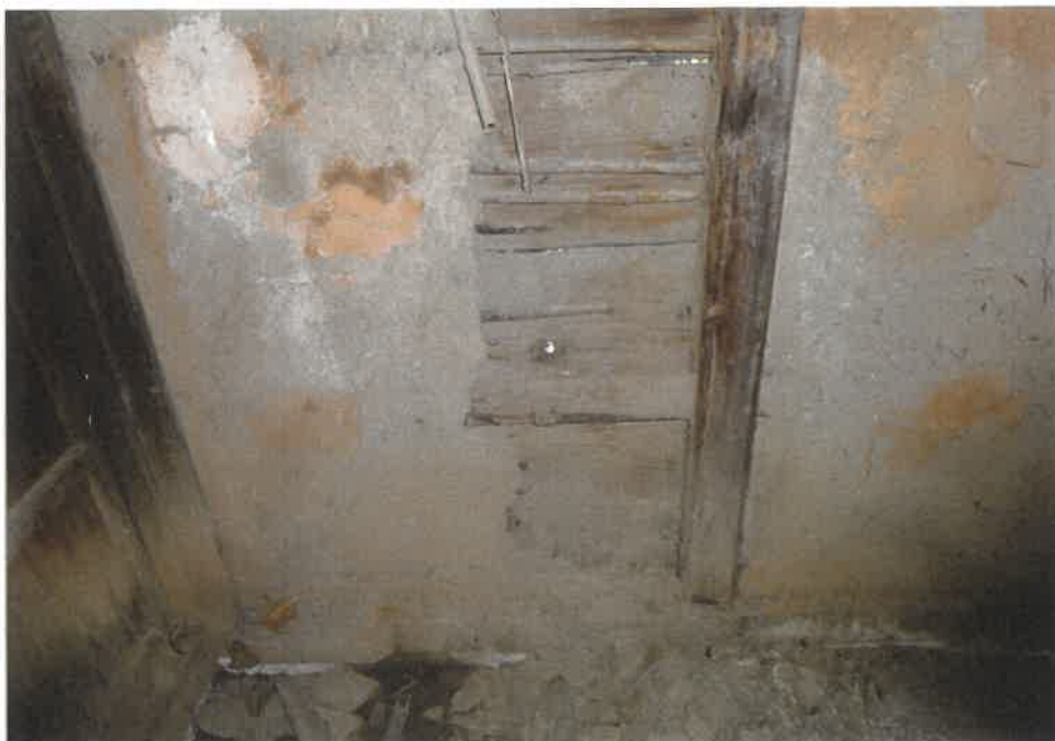
④屋内の状況 壁の状況 (物件3)
