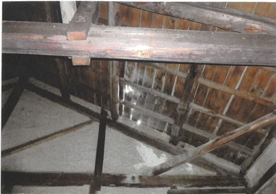
③屋内の状況 天井の状況 (物件3)
