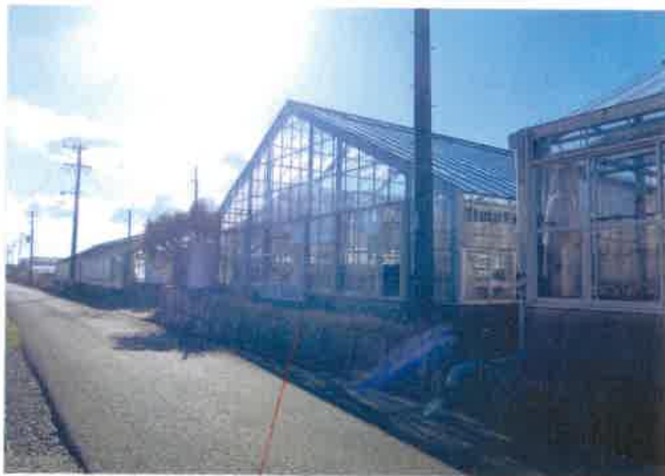
④北東側境界 付近の状況
