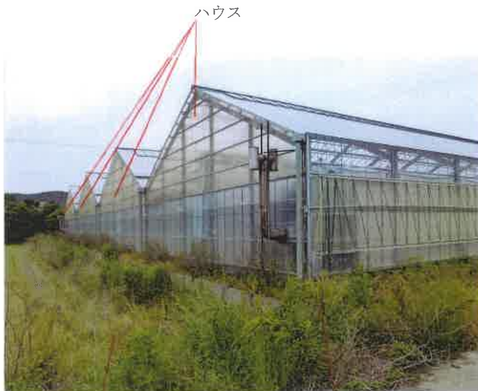
①南西側境界 付近の状況
