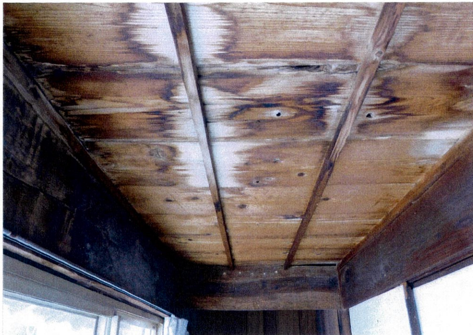
⑤屋内の状況 広縁の天井 の状況 (主である 建物)
