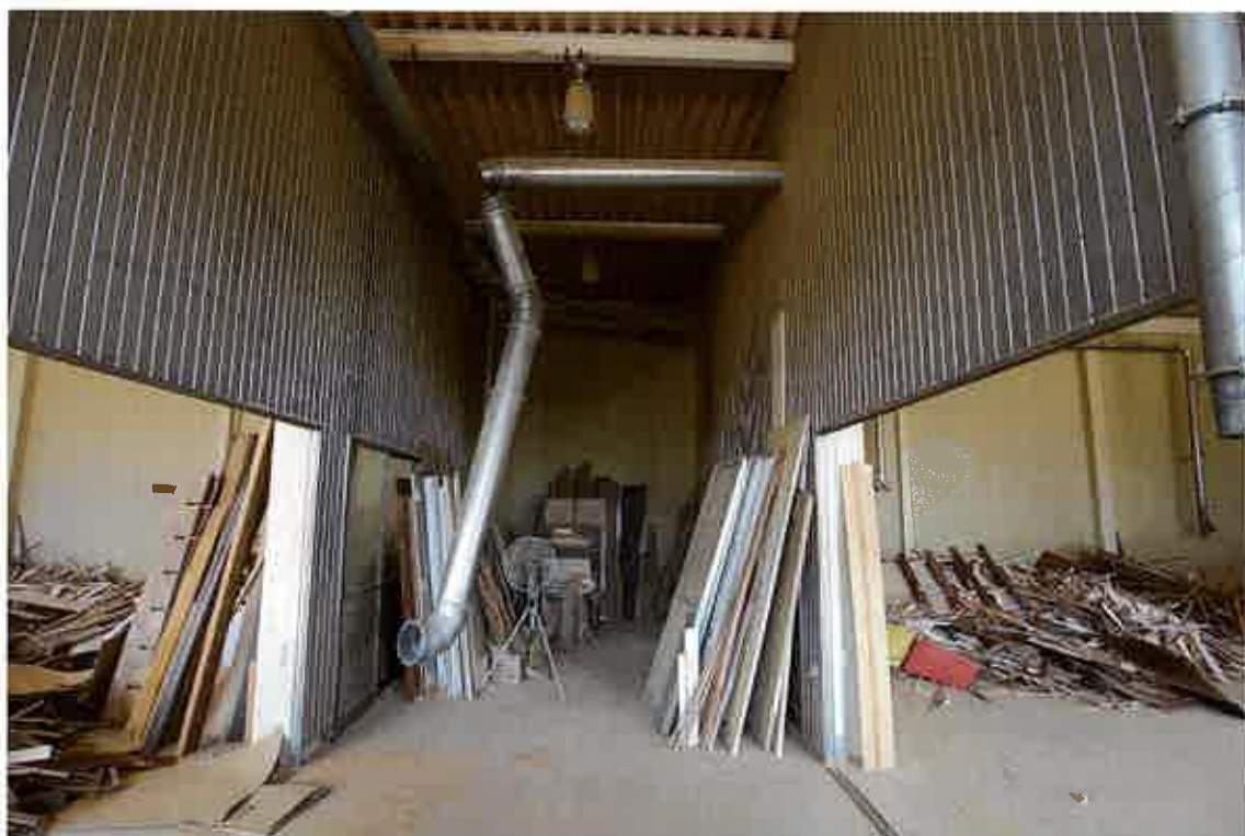
物件 8 建物室内(未登記増築部分)
