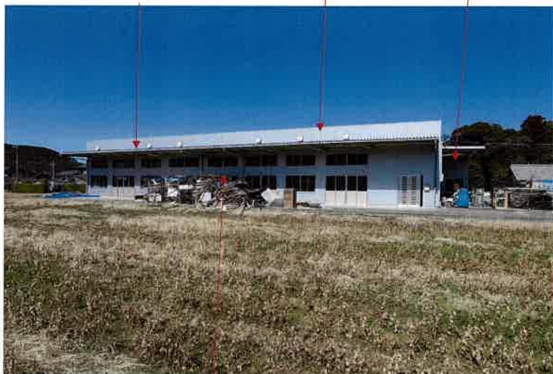
物件 8 建物(未登記増築部分)
