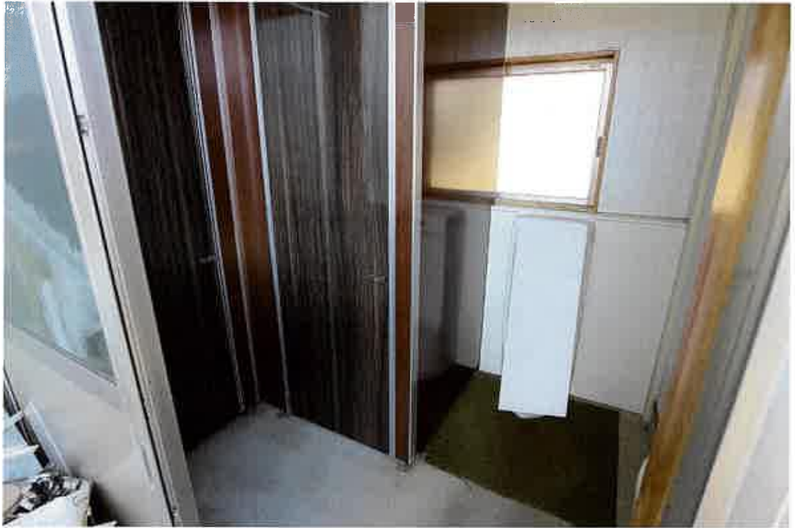
物件 8 建物室内(未登記部分 トイレ)
