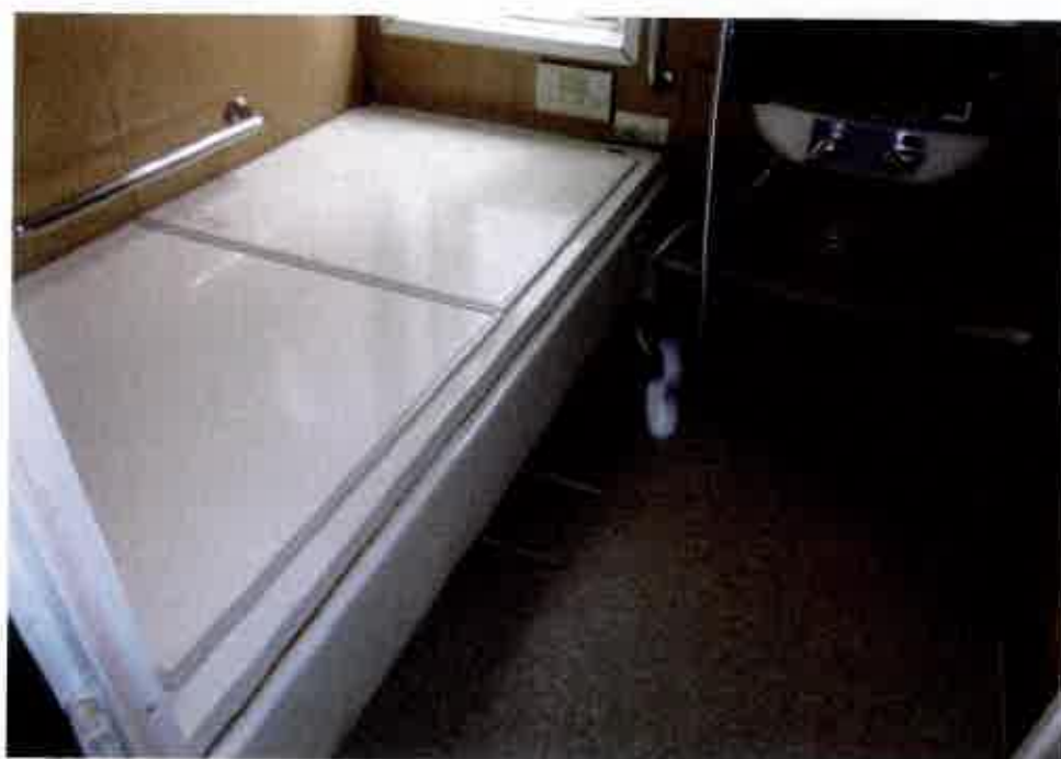
④屋内の状況 浴室
