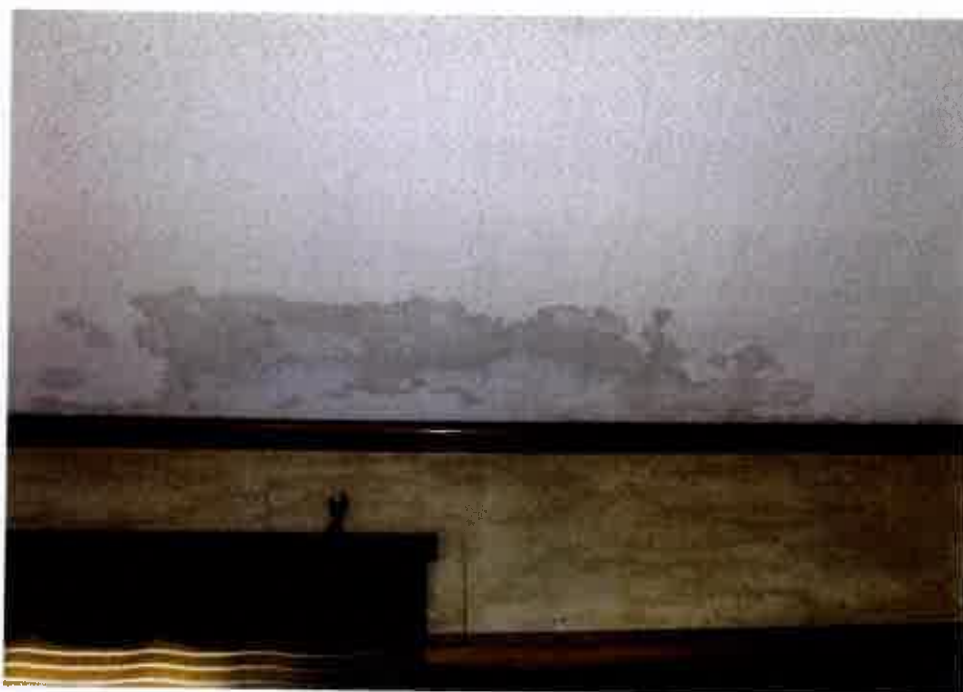
⑨屋内の状況 Lの天井の 状況 (符号1の 附属建物)
