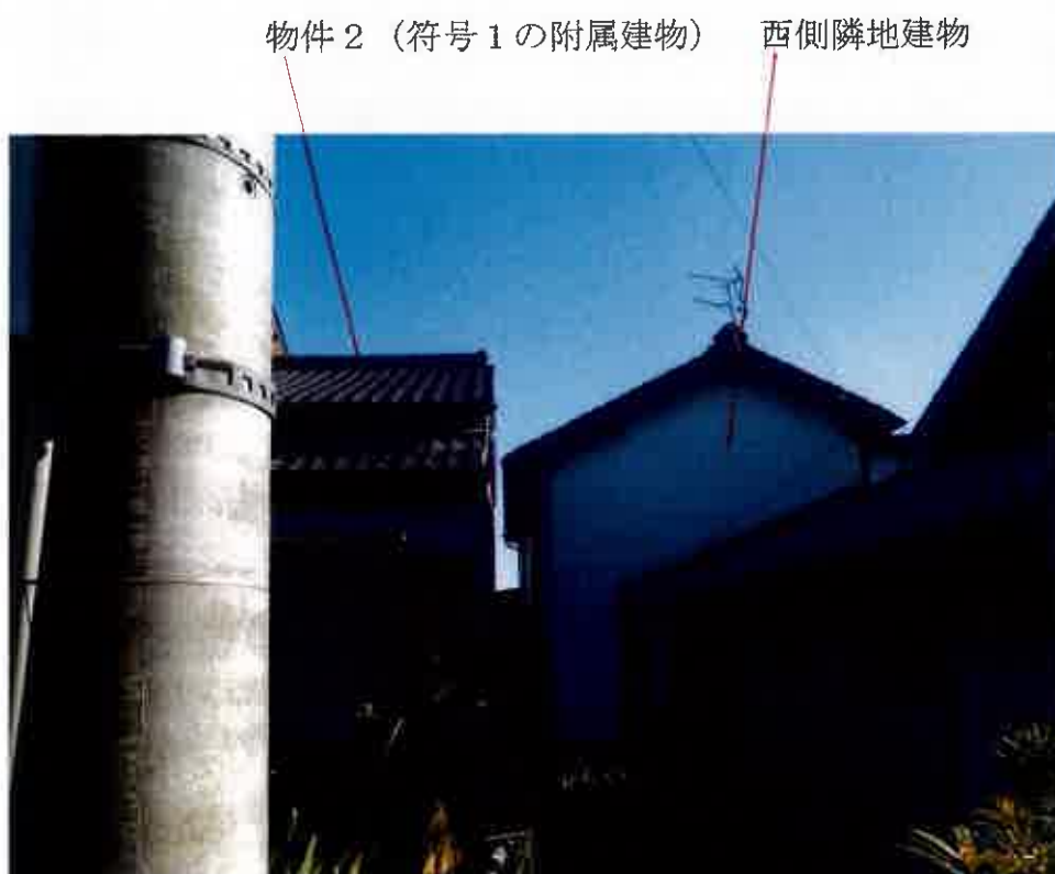
⑩屋外の状況 西側境界 付近の状況
