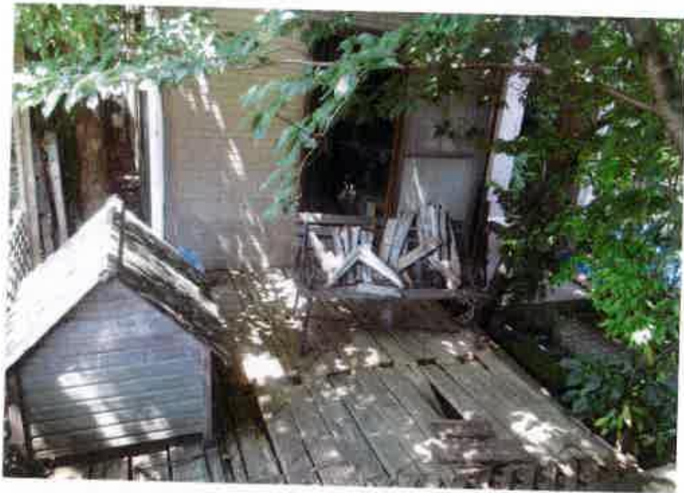
屋外の状況（ウッドデッキ）
