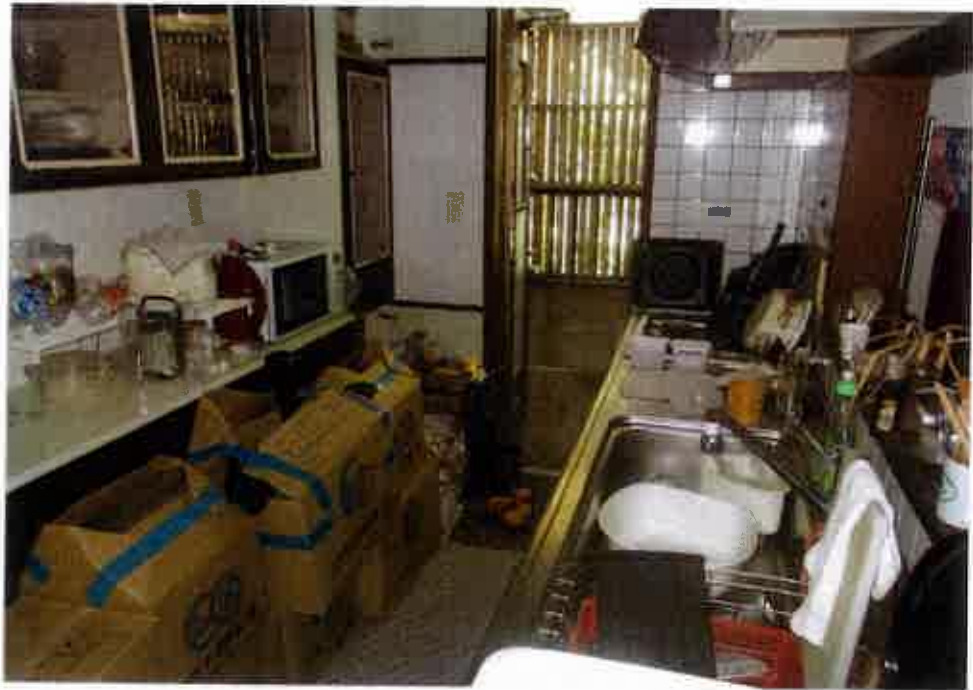
屋内の状況（1階 キッチン）
