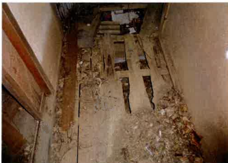
④屋内の状況 ホールの床 の状況 (主である 建物)
