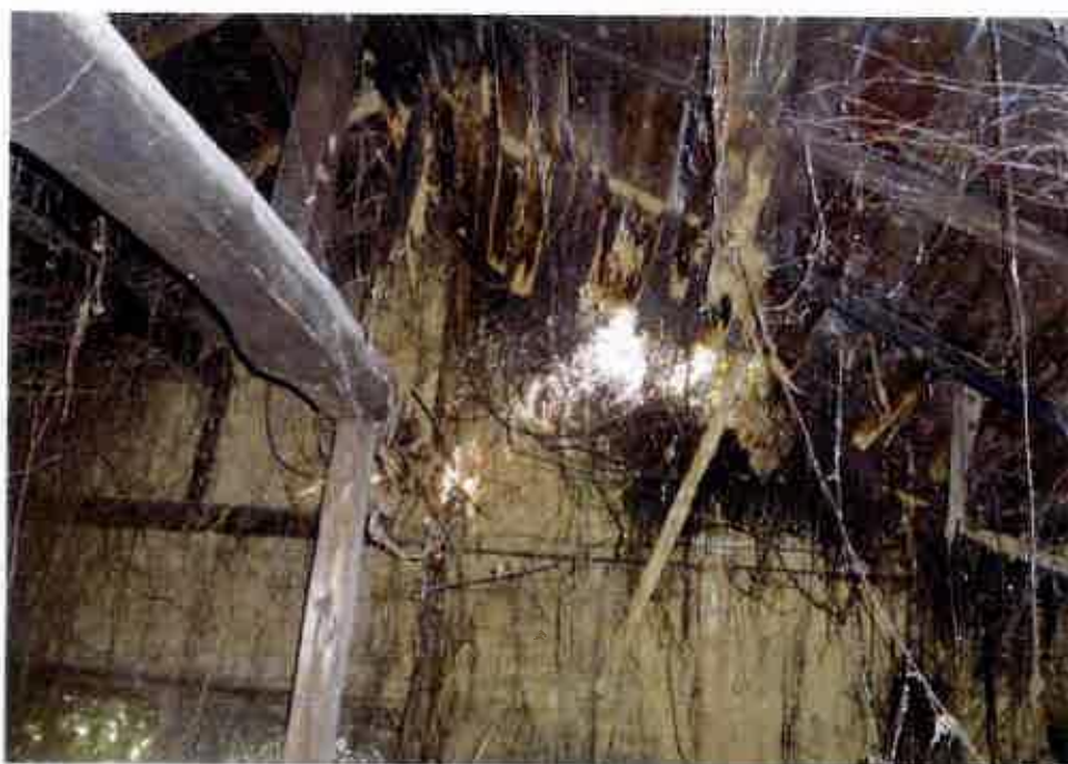
⑨屋内の状況 物置3の天井 の状況 (符号1の 附属建物)
