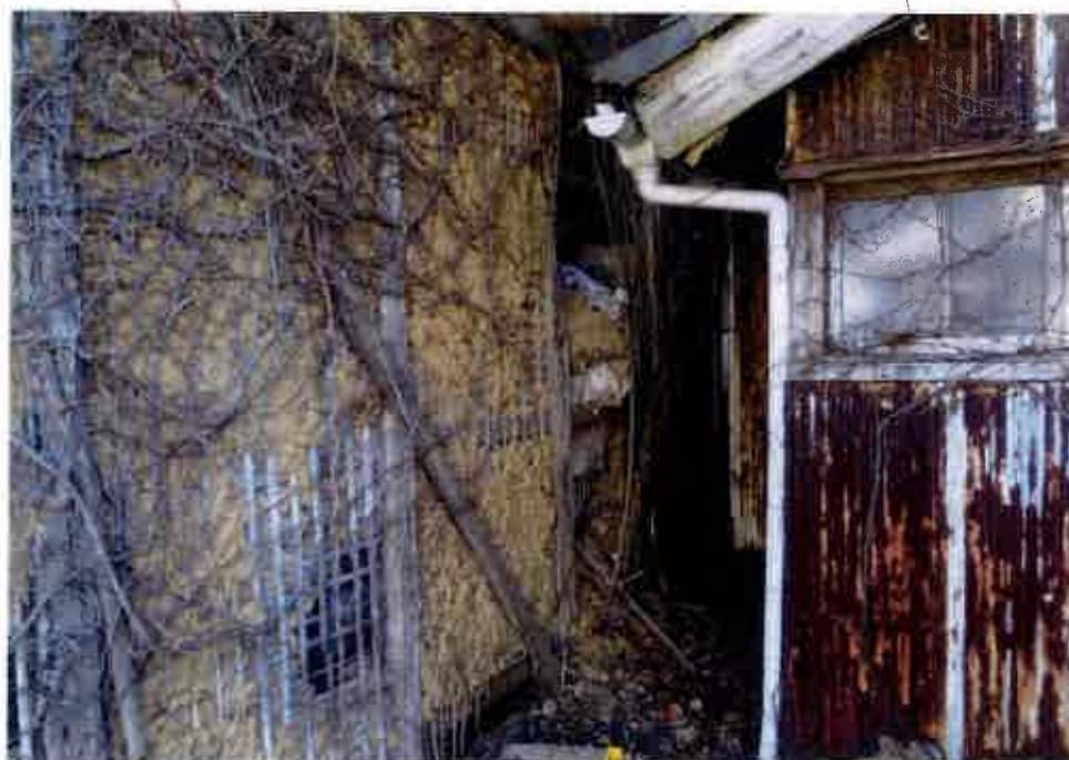
⑩屋外の状況 東側壁面の 状況 (符号1の 附属建物)
