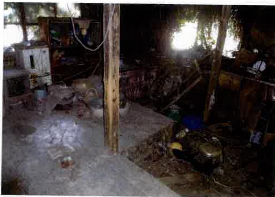
⑦屋内の状況 物置3 (符号1の 附属建物)
