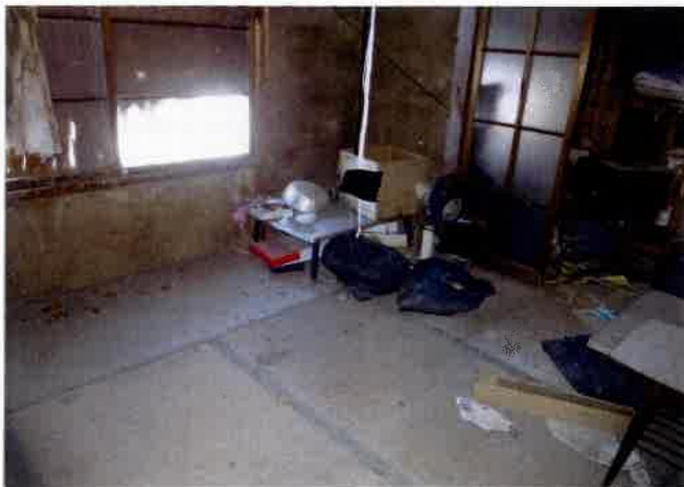
③屋内の状況 和室1 (主である 建物)
