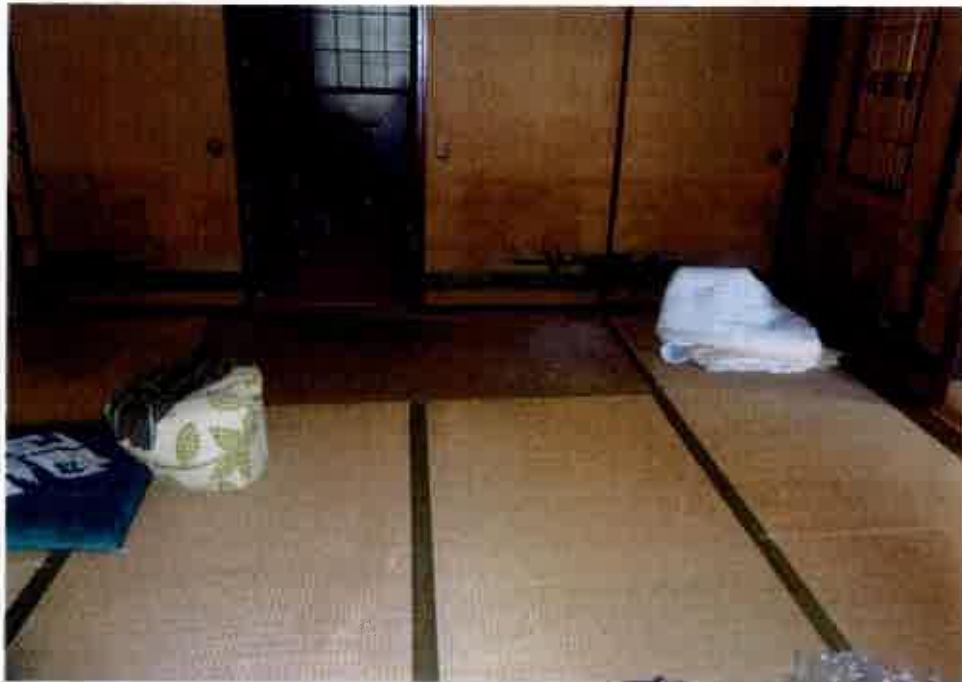
⑤屋内の状況 和室2 (物件4) (主である 建物)
