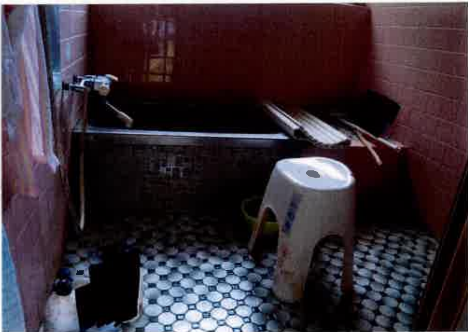
⑧屋内の状況
