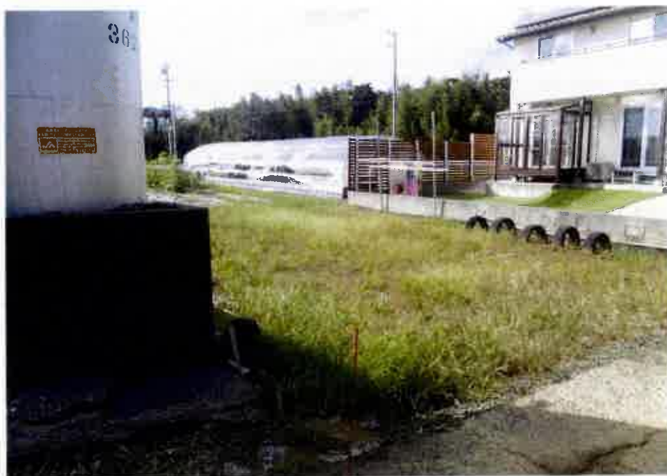
①南東側境界 付近の状況
