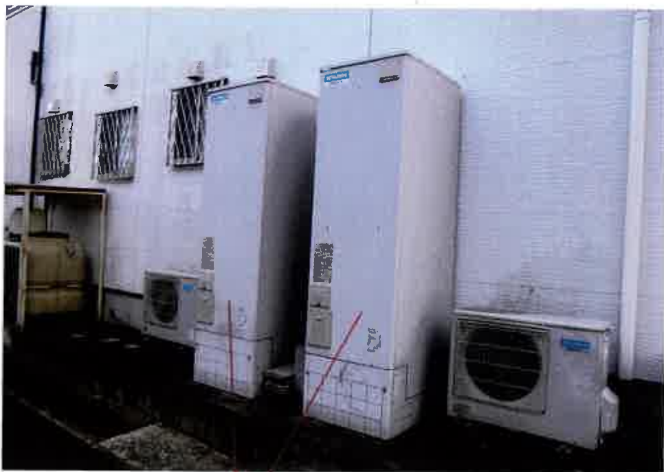
⑦屋外の状況
