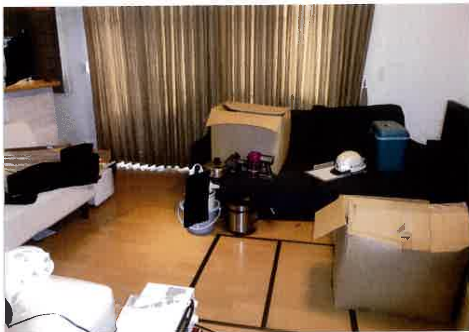
④屋内の状況 1階LD(壁)
