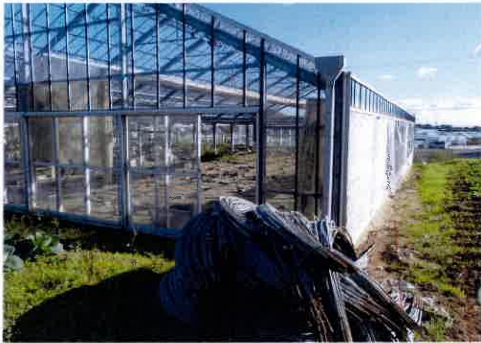
③北西側境界 付近の状況
