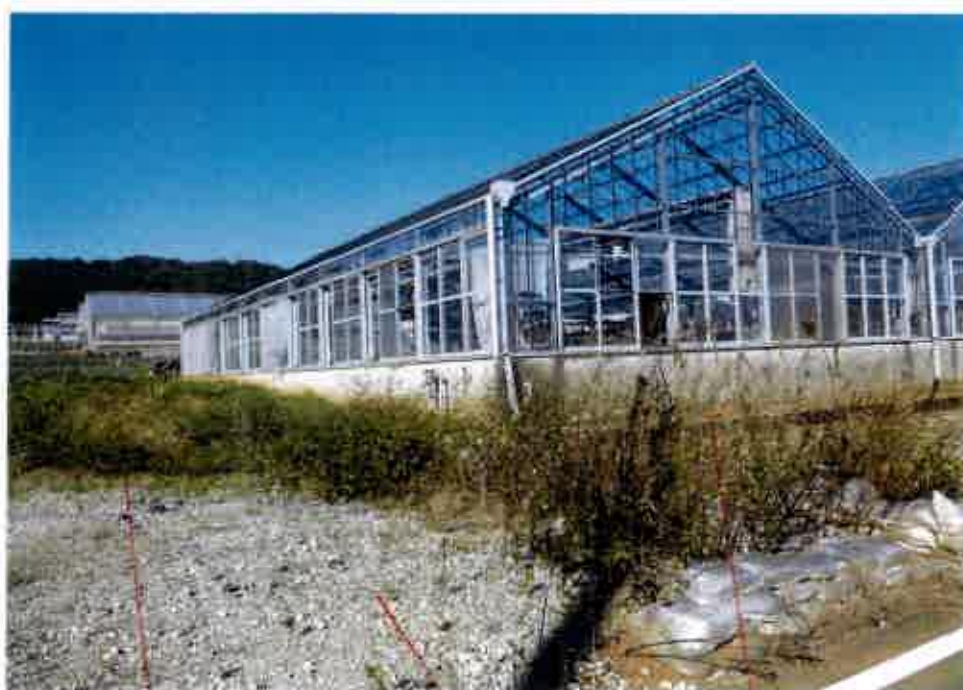
②南西側境界 付近の状況
