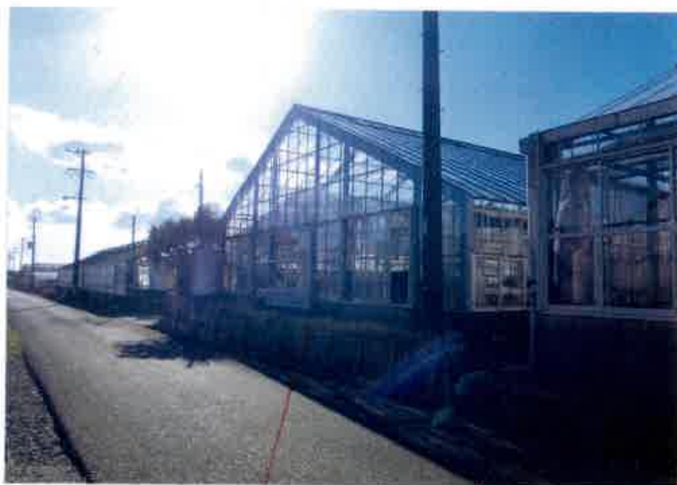
④北東側境界 付近の状況
