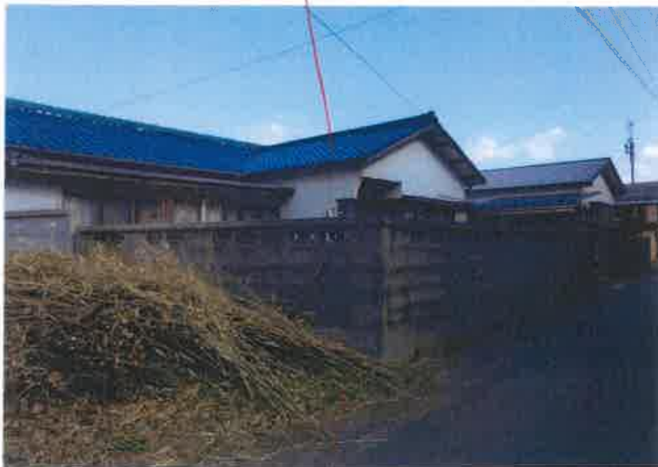
①南西側境界 付近の状況
