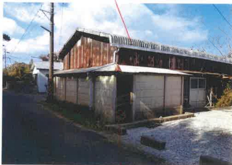
②南東側境界 付近の状況
