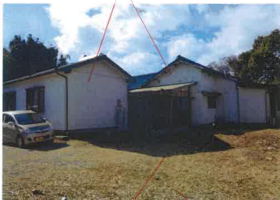
④屋外の状況
