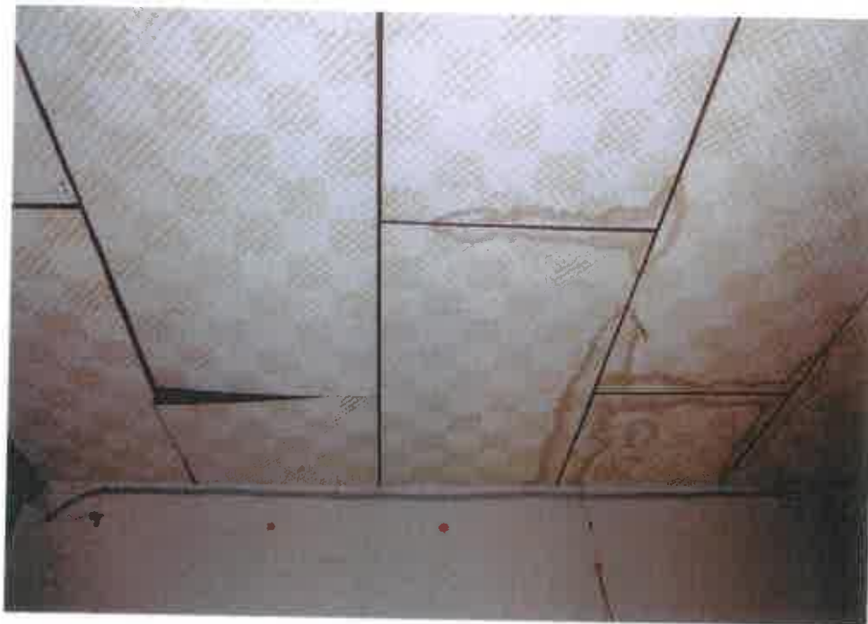
⑨屋内の状況 板間の天井の 状況 (物件2)
