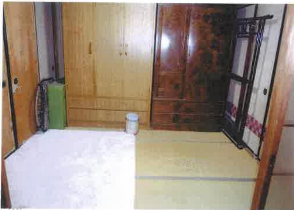
③屋内の状況 和室1 (物件2)
