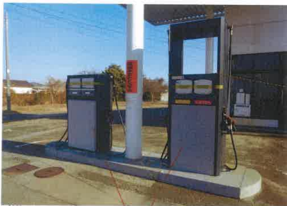
⑪屋外の状況
