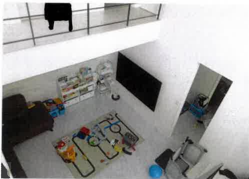
2階部分から撮影(吹抜の状況)
