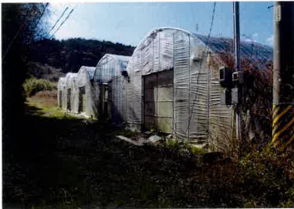
④ビニール ハウスの状況
