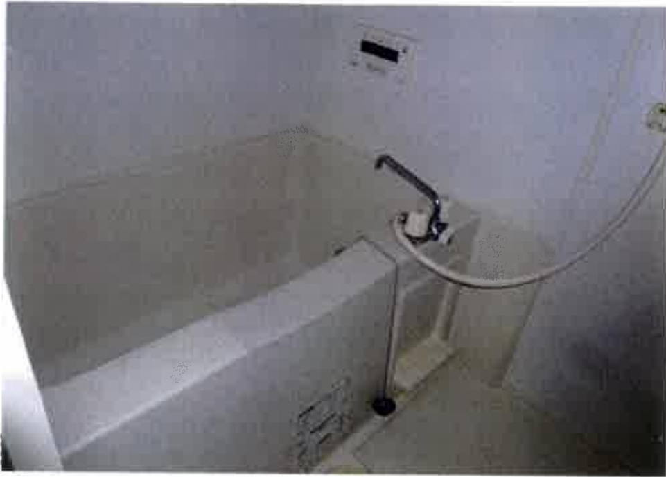
⑦屋内の状況 浴室 (物件3) (8号室)
