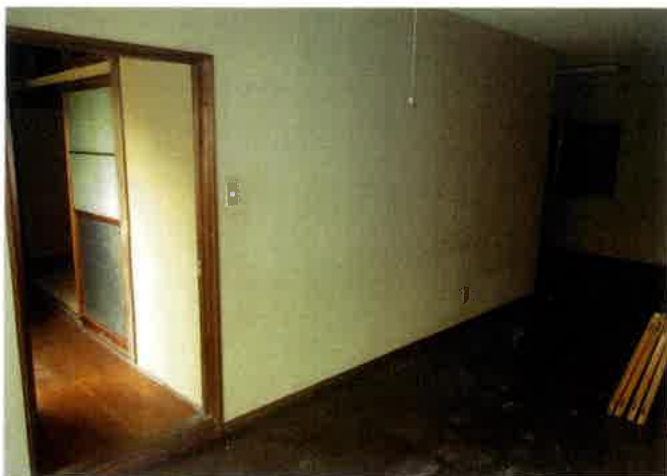
屋内の状況（洋室 1）
