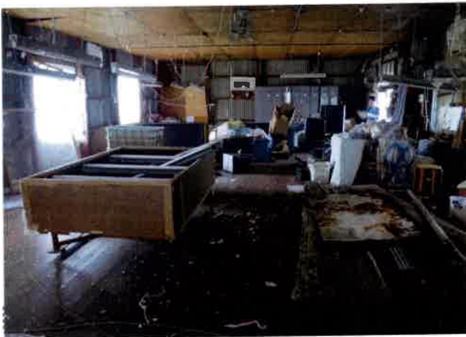
②屋内の状況
