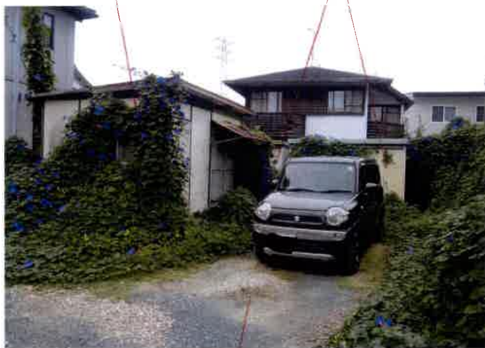
④屋外の状況
