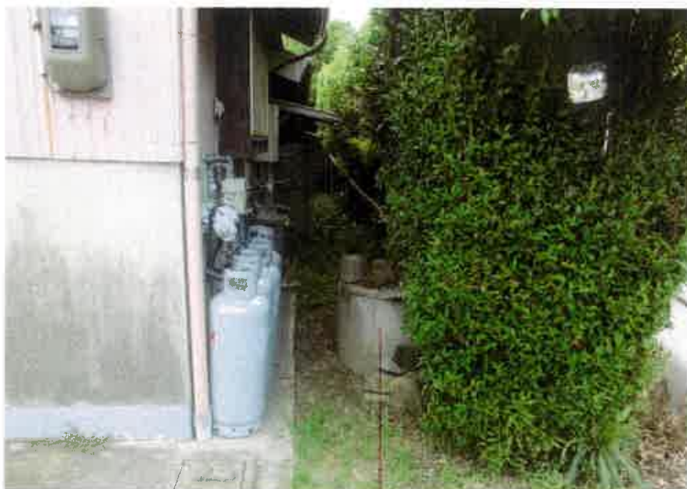
屋外の状況（物件 2 土地上に存在する井戸）
