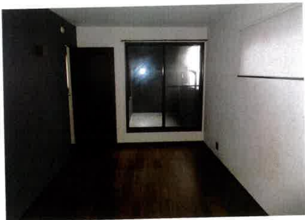
屋内の状況（2階 洋室1からベランダ方向撮影）
