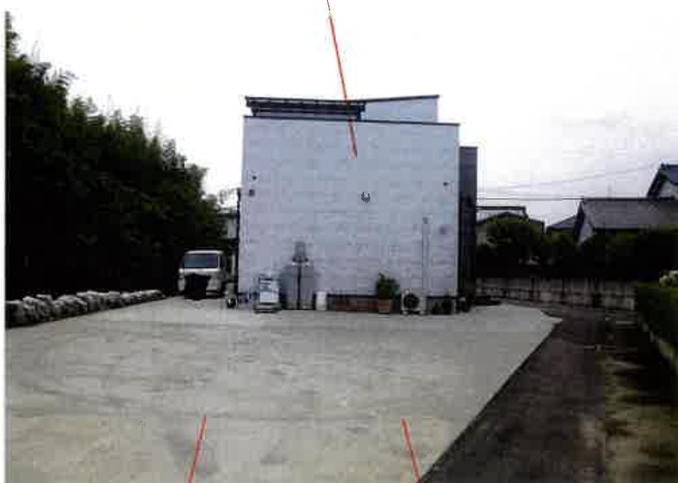
②屋外の状況 (東側から撮影)
