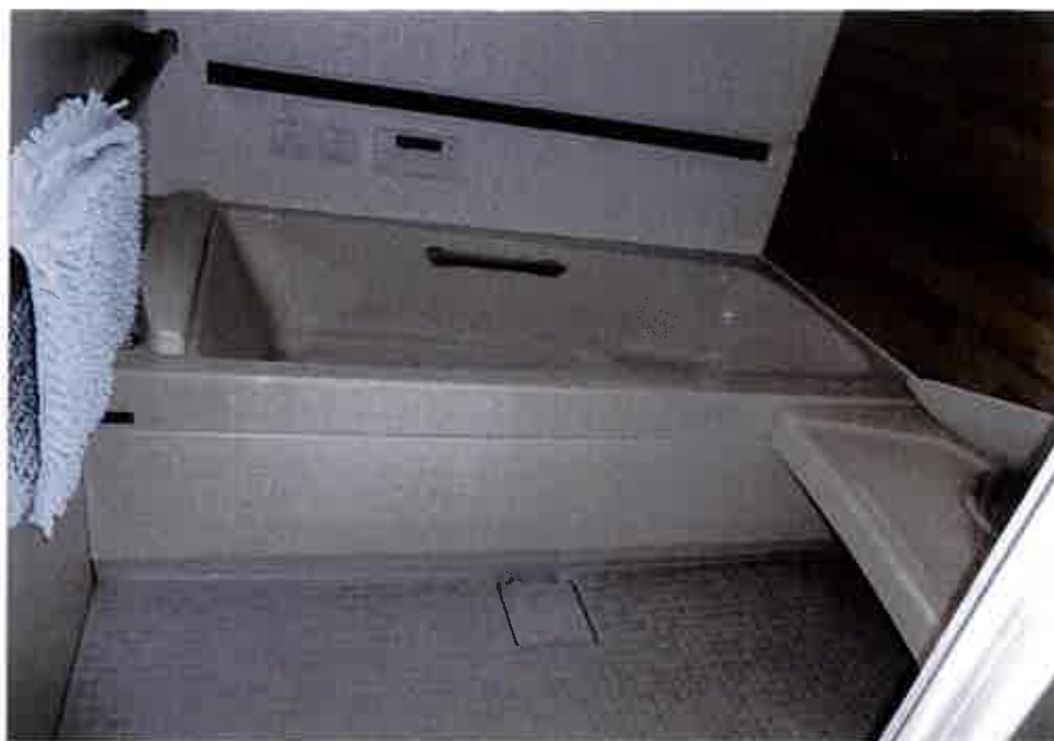
⑤屋内の状況 浴室
