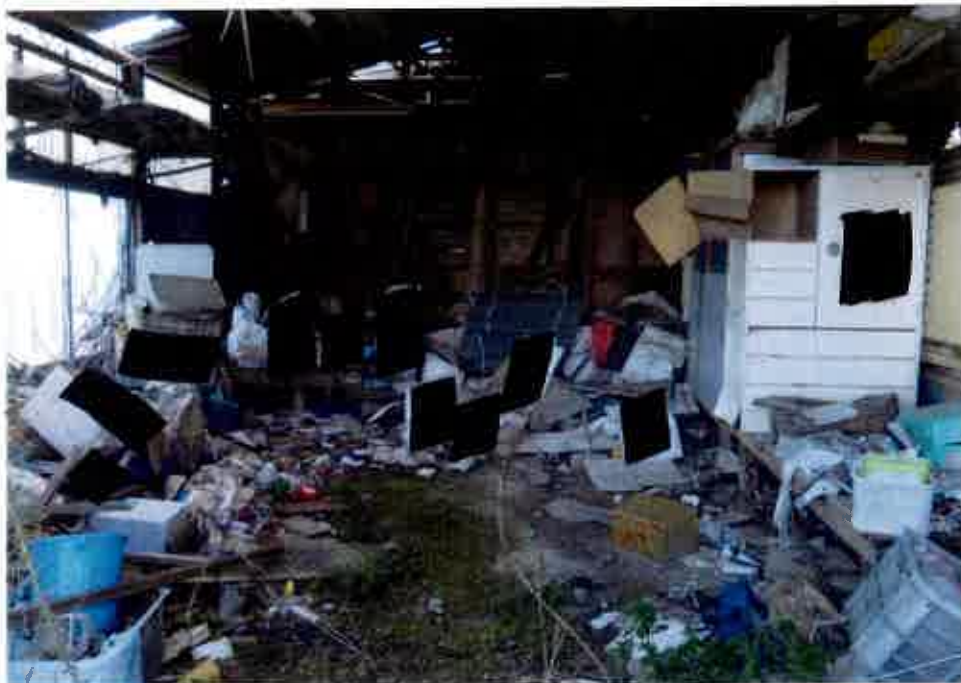
⑥屋内の状況 物置 （符号1の 附属建物）
