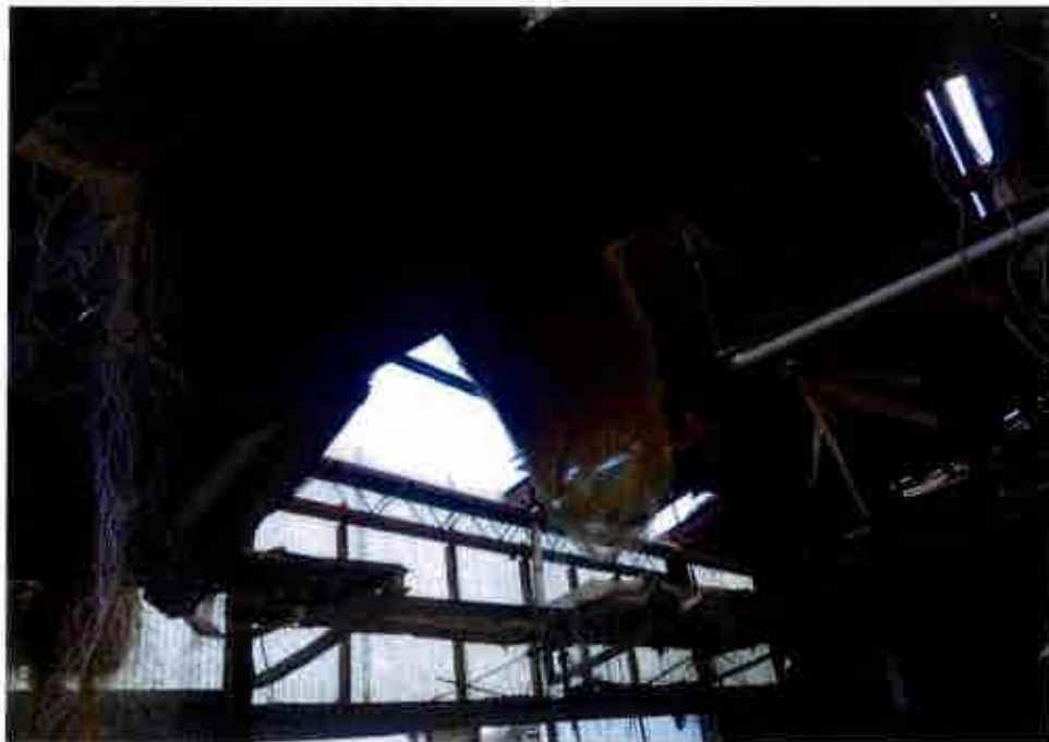
⑦屋内の状況 物置の天井 の状況 (符号1の 附属建物)
