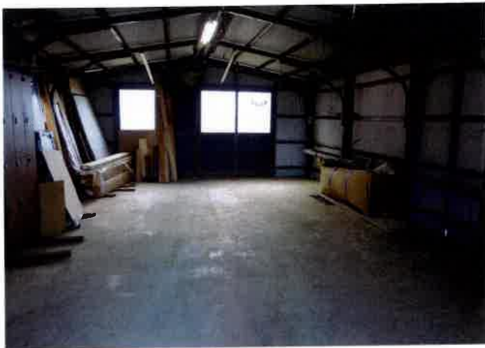
⑨屋内の状況 物置 (符号2の 附属建物)
