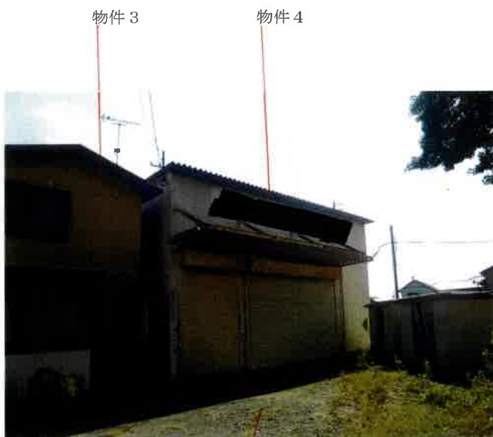
④屋外の状況
