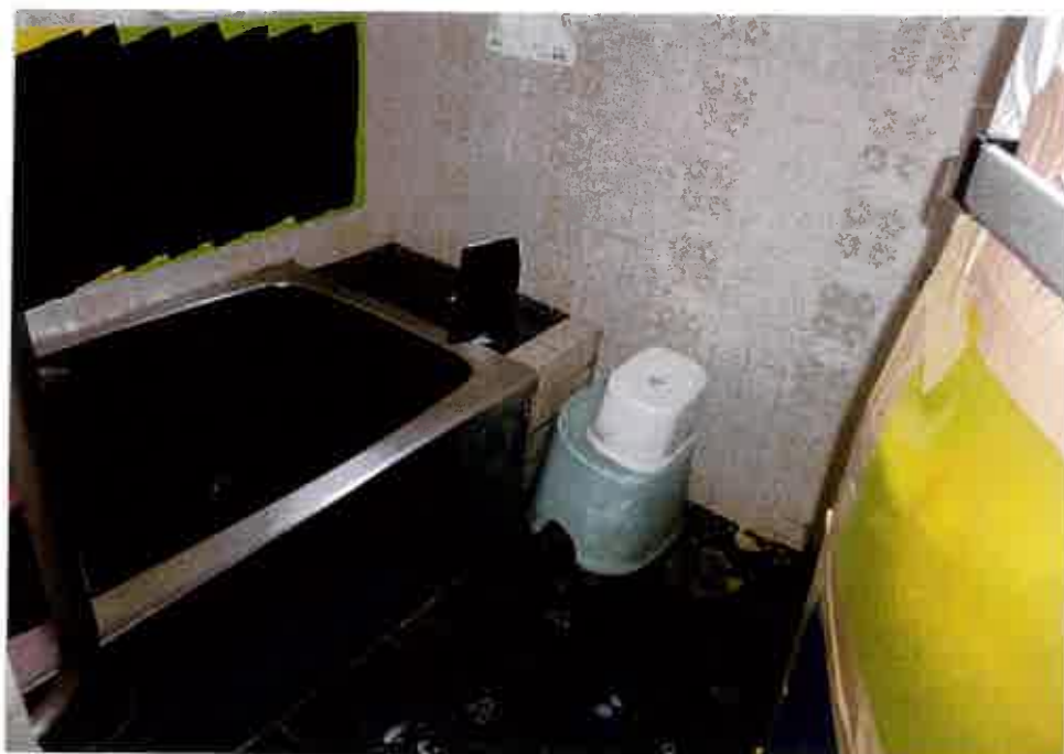
⑤屋内の状況 浴室
