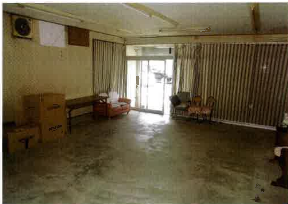
屋内の状況（1階 店舗）
