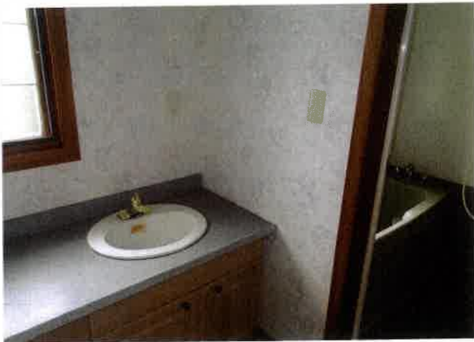
屋内の状況(3階 洗面所・浴室)
