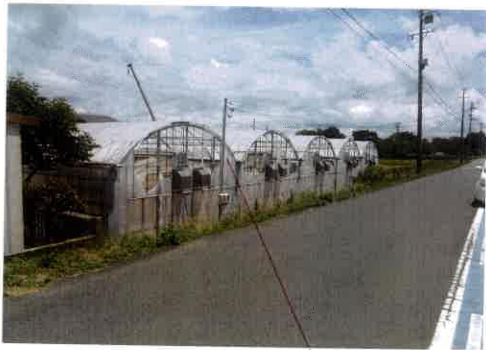
物件2土地 接道状況及び引込ポールの位置
