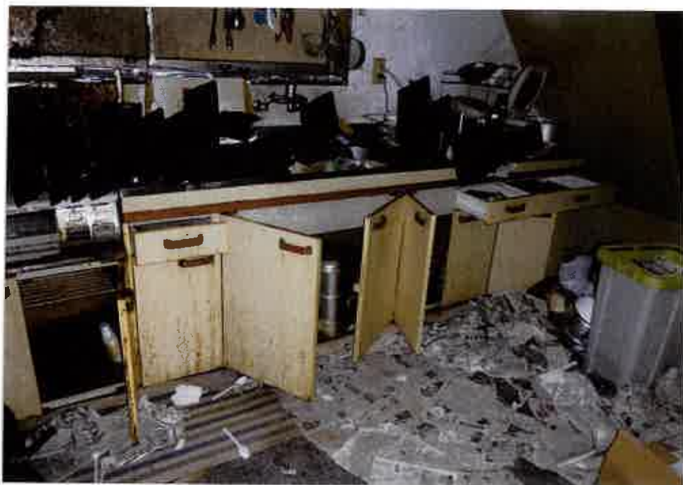
③屋内の状況 台所・食堂 (物件2)
