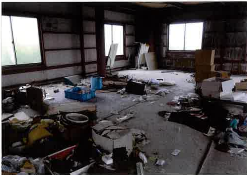
⑧屋内の状況 倉庫 (物件5)
