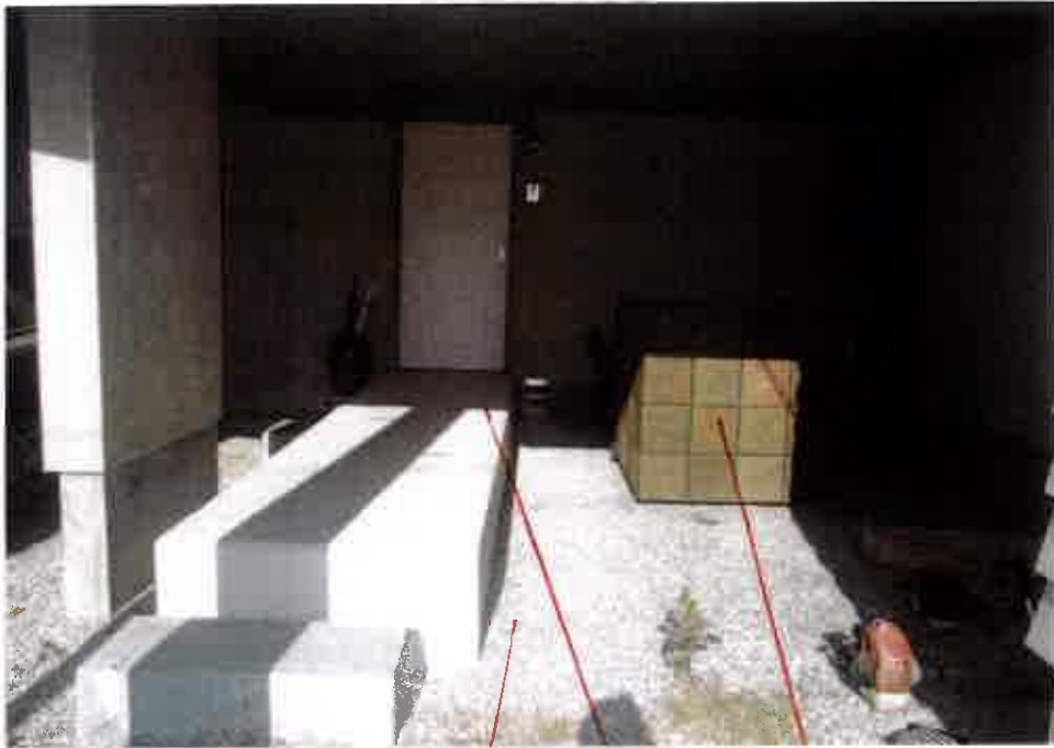
物件1 オブジェ 屋外の状況 (玄関の通路の状況)
