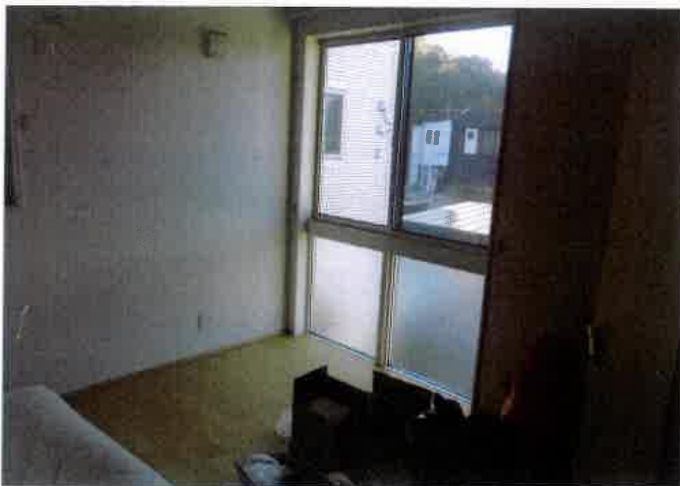
屋内の状況（2階 洋室1）
