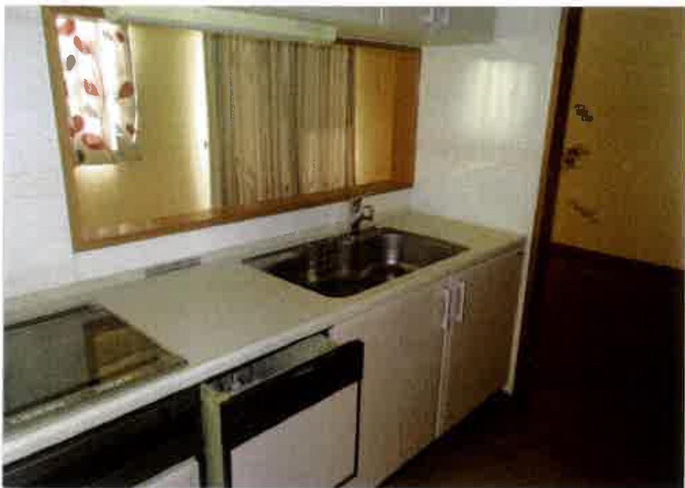
屋内の状況（2階 キッチン）
