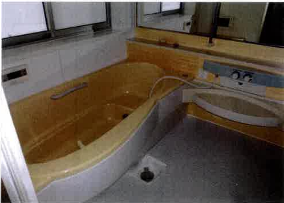
④屋内の状況 浴室
