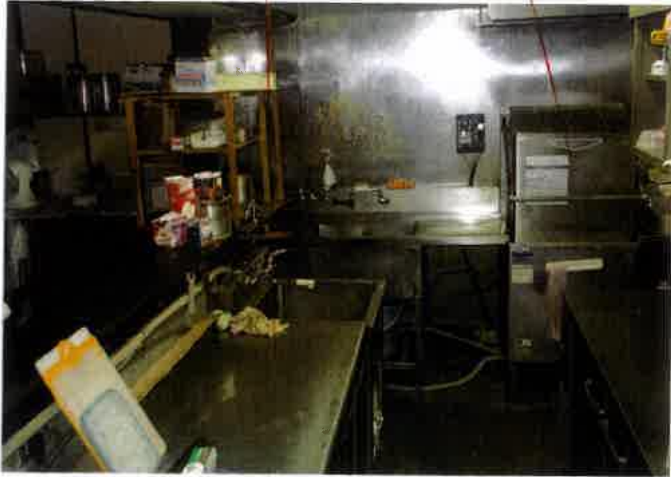
屋外の状況（厨房機器の設置状況）
