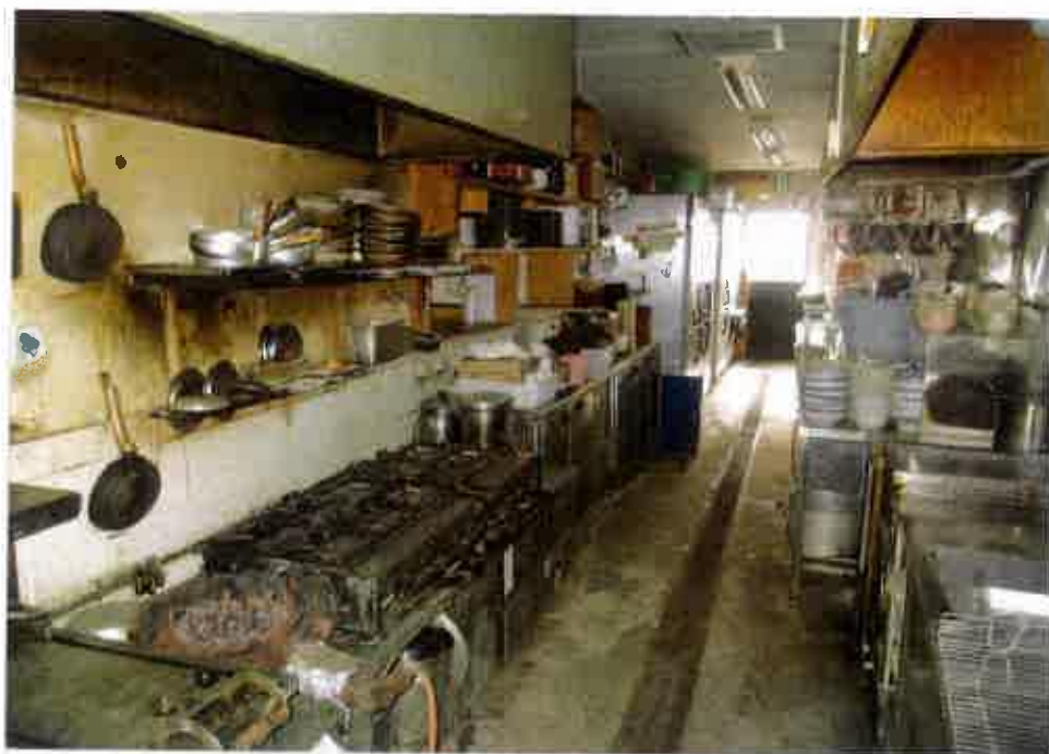
屋内の状況（厨房）
