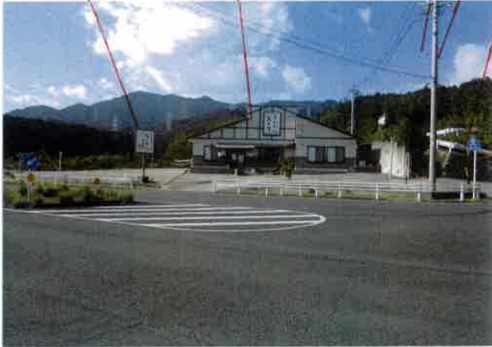
屋外の状況 (物件1 0 土地乃至物件2 0 土地及び物件2 1 建物 全景)
