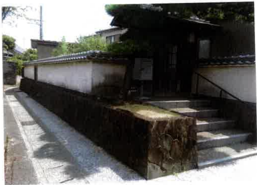
屋外の状況 (物件 1 土地 門扉)
