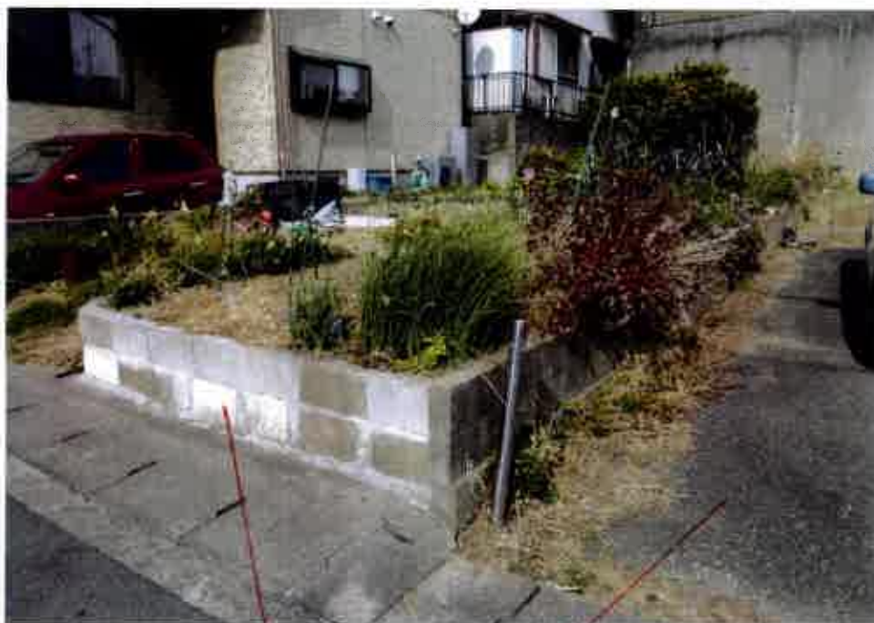
④南側境界 (南角) 付近の状況
