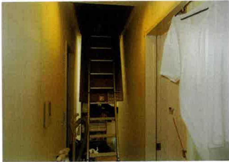
洋室3 (壁面損傷の跡)
