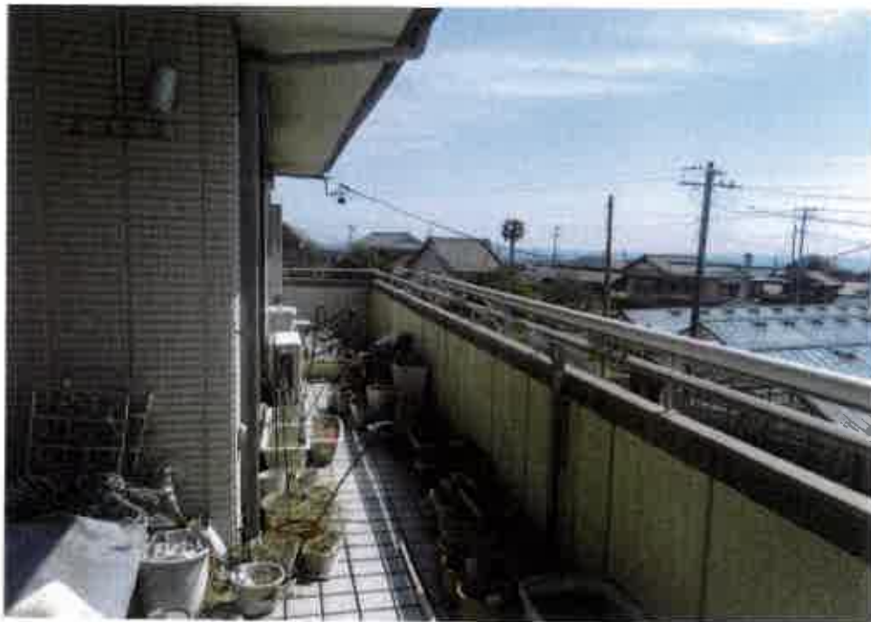
屋外の状況 (2階 バルコニー)
